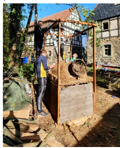
Das lasierte Holz wurde dann an der Unterkonstruktion befestigt und die Dachkonstruktion samt Wellblech konnte angebracht werden.
