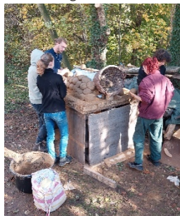
Nachdem Unterkonstruktion und Lehmballen fertig waren, konnte der Ofen am zweiten Tag mithilfe von Sand und Zeitungspapier gebaut werden.
