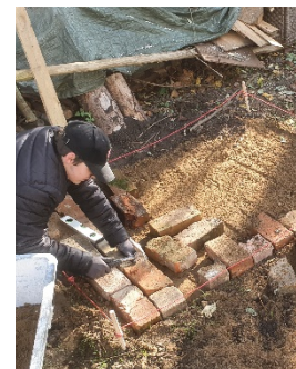
Für den Lehmofen samt Unter- und Dachkonstruktion war ein stabiles Fundament aus Ziegelsteinen nötig. Das war eine der ersten Arbeiten.
